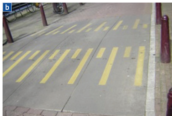
Rys. U.2.1.2 Przykłady zastosowania progów listwowych przed przejściami dla pieszych: a) w Holandii (Amsterdam), b) w Polsce Źródło: Źródło: a) fot. K. Jamroz, b) Ekkom [9]
