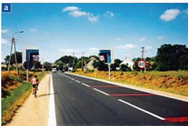
Rys. U.18.2 Przykłady środków uspokajania ruchu na wlotach do miejscowości: a) brama wjazdowa w miejscowości Kobylnica Słupska (droga krajowa nr 21), b) wyspa wjazdowa w miejscowości Trzuszczyn (droga krajowa nr 25)
