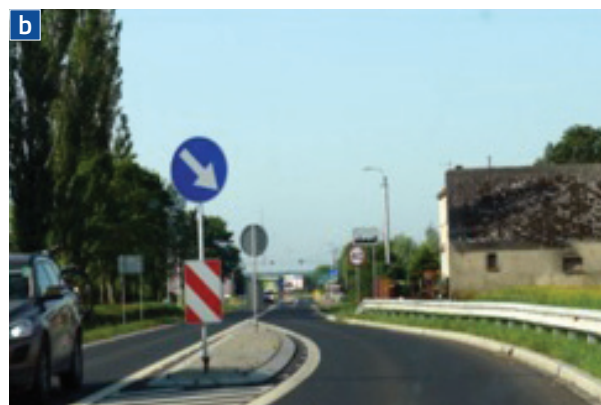
Rys. U.18.2 Przykłady środków uspokajania ruchu na wlotach do miejscowości: a) brama wjazdowa w miejscowości Kobylnica Słupska (droga krajowa nr 21), b) wyspa wjazdowa w miejscowości Trzuszczyn (droga krajowa nr 25)
