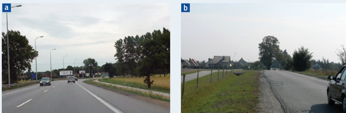
Rys. 6.3 Przykłady dobrych rozwiązań ruchu pieszego i rowerowego: a) przy drodze krajowej nr 7, b) przy powiatowej drodze dojazdowej do Chojnic
