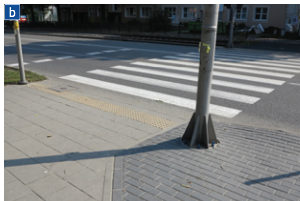
Rys. U.15.2 Przykłady urządzeń (rampy, linie prowadzące) dla osób niepełnosprawnych: a) w Niemczech, b) w Polsce
