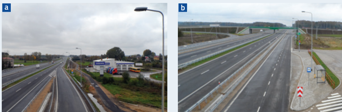
Rys. 6.2 Przykłady rozwiązań ruchu pieszego i rowerowego wzdłuż dróg strategicznych (ekspresowych): a) ciąg pieszo-rowerowy wzdłuż drogi ekspresowej S-8, b) dojście do przystanku autobusowego
