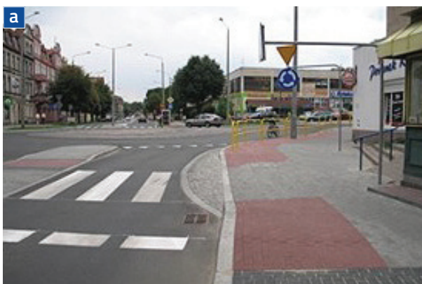
Rys. U.10.2 Przykłady zawężenia jezdni przy przejściach dla pieszych w Budapeszcie i w Katowicach Źródło: a) projekt pilotażowy PLMN-KUJ/10, b) fot. A. Zalewski
