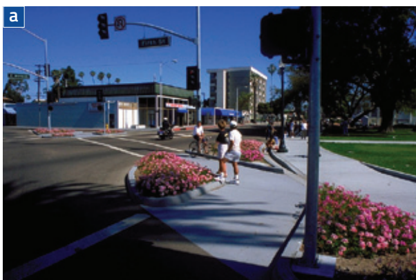
Rys. U.14.2 Przykłady zmniejszenia promienia skrętu w prawo na skrzyżowaniu w USA Źródło: fot. U.S. Federal Highway Administration
