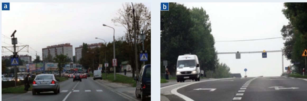
Rys. 7.55 Przykłady zastosowania sygnału ostrzegawczego nad przejściami dla pieszych poza skrzyżowaniami, aktywne przejście dla pieszych: a) w Krakowie, b) na drodze krajowej nr 7
