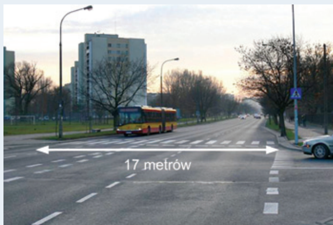
Rys. 3.10 Przykład istniejącego przejścia dla pieszych i zagrożeń dla pieszych użytkowników drogi, zidentyfikowanych przez inspektora brd
