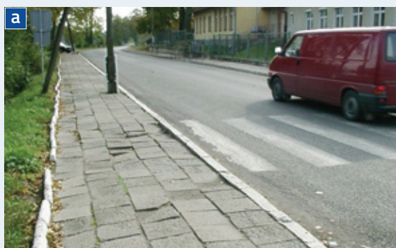
Rys. 2.12 Przykład nierówności nawierzchni stanowiących zagrożenie dla pieszych: a) na chodniku przy drodze wojewódzkiej, b) na bardzo uczęszczanym przejściu dla pieszych przez ulicę główną w Gdańsku,
