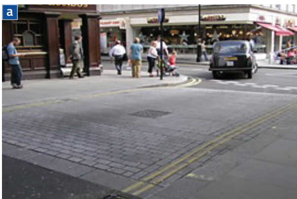
Rys. U.13.2 Przykłady chodnika poprzecznego na wlotach ulic podporządkowanych: a) w Wielkiej Brytanii b) w Belgii Źródło: a) fot. A. Rys, b) SPW Wallonie [97]
