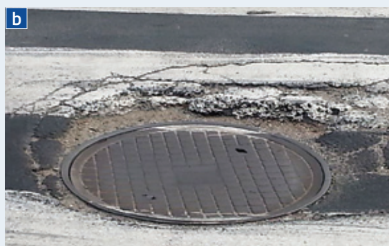
Rys. 2.12 Przykład nierówności nawierzchni stanowiących zagrożenie dla pieszych: a) na chodniku przy drodze wojewódzkiej, b) na bardzo uczęszczanym przejściu dla pieszych przez ulicę główną w Gdańsku,
