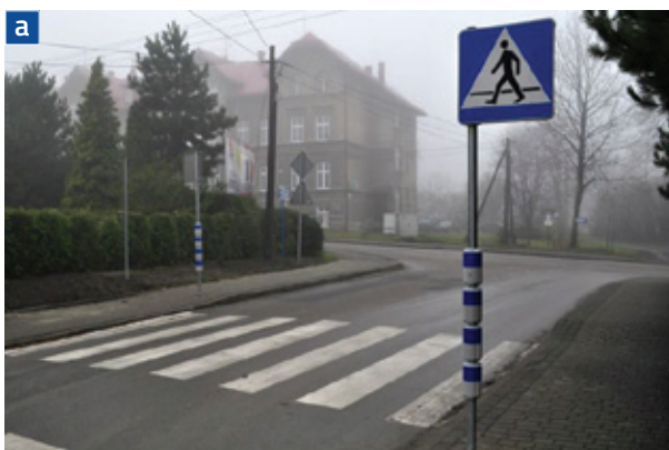
Rys. U.24.2 Przykłady aktywnego oznakowania przejść dla pieszych; a) w Bytomiu, b) w Szwajcarii Źródło: a) www.roadservice.pl , b) G. Scaramuzza [93]
