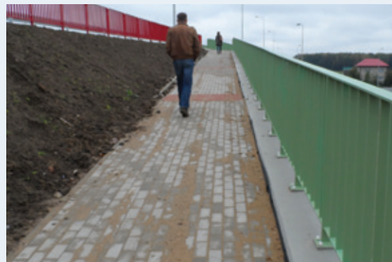
Rys. 6.9 Wygrodzenia i balustrady stosowane w celu powstrzymania pieszych przed wtargnięciem na jezdnię lub upadek ze skarpy
