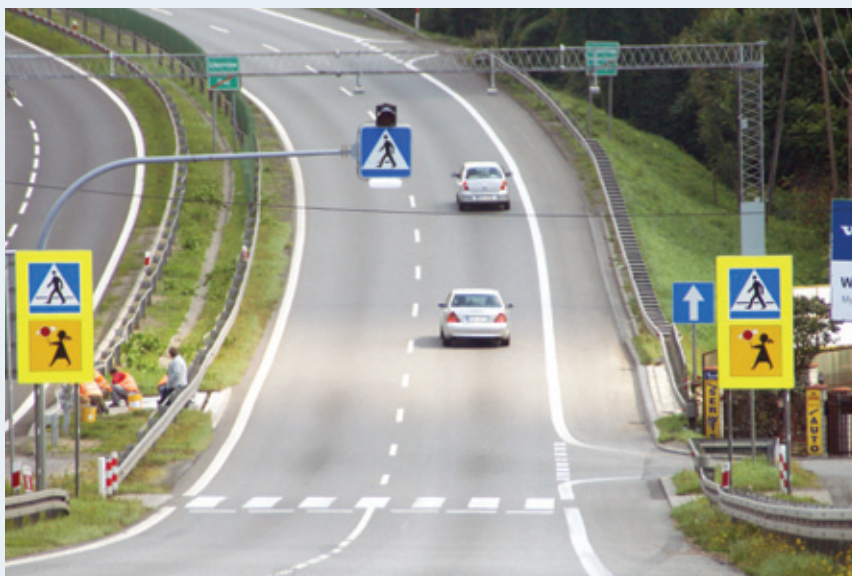
Rys. 3.7 Widok analizowanego przejścia dla pieszych na drodze krajowej nr 7 w Mogilanach, na kierunku Kraków → Zakopane Źródło: fot. M. Kieć [60]
