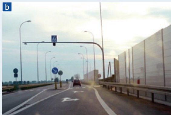
Rys. 7.12 Przykład wyznaczonego przejścia dla pieszych z sygnalizacją świetlną ostrzegawczą na drogach krajowych
