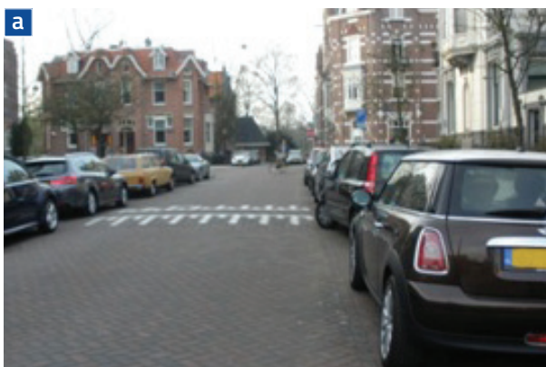
Rys. U.2.1.2 Przykłady zastosowania progów listwowych przed przejściami dla pieszych: a) w Holandii (Amsterdam), b) w Polsce Źródło: Źródło: a) fot. K. Jamroz, b) Ekkom [9]
