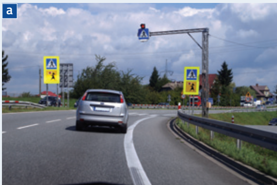
Rys. 7.12 Przykład wyznaczonego przejścia dla pieszych z sygnalizacją świetlną ostrzegawczą na drogach krajowych
