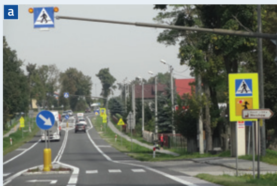
Rys. 7.46 Przykłady umieszczenia znaków pionowych na tle folii odbłaskowo-fluorescencyjnej: a) na drodze krajowej nr 7, b) na ul. Jana Pawła II w Gdańsku-Zaspie
