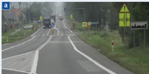
Rys. 7.8 Przykłady wyznaczonego przejścia dla pieszych z wyspą azylu: a) na drodze krajowej nr 7, b) w Warszawie
